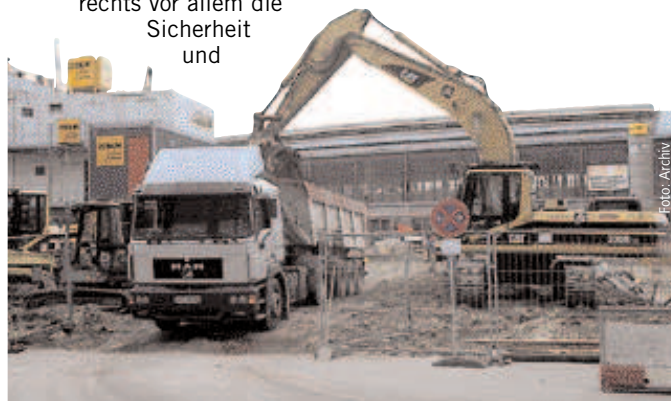
Das Halteverbot schützt nicht die Interessen des Bauunternehmers
